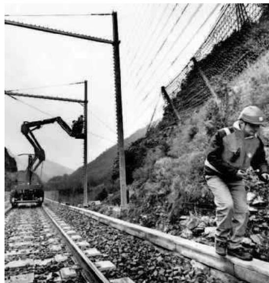
Des filets de protection et murs de soutènement préservent la ligne d'éventuels éboulements, fréquents en montagne. D. LE DÉODIC
