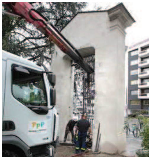
Les grilles, réalisées par les services de la Ville, viennent magnifier l'édifice. © MARC ZIRNHELD
