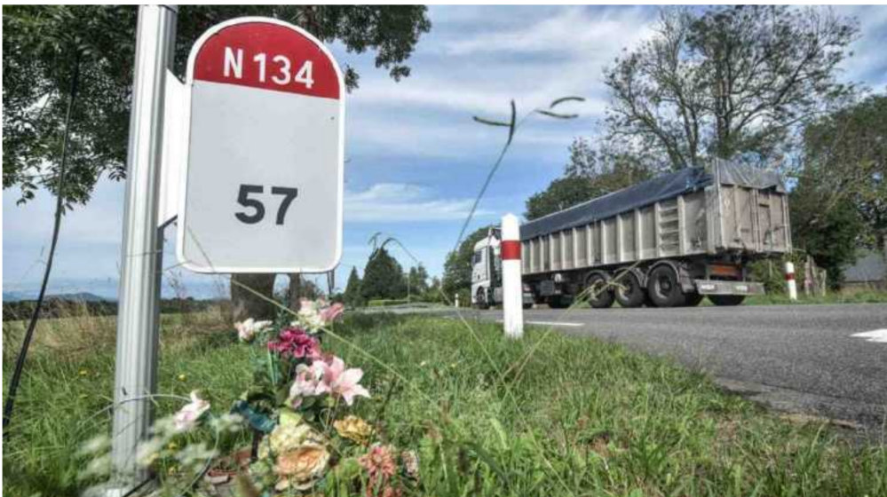
Le projet de sécurisation concerne l'une des portions les plus fréquentées et les plus accidentées de la RN 134. PHOTOS QUENTIN TOP
