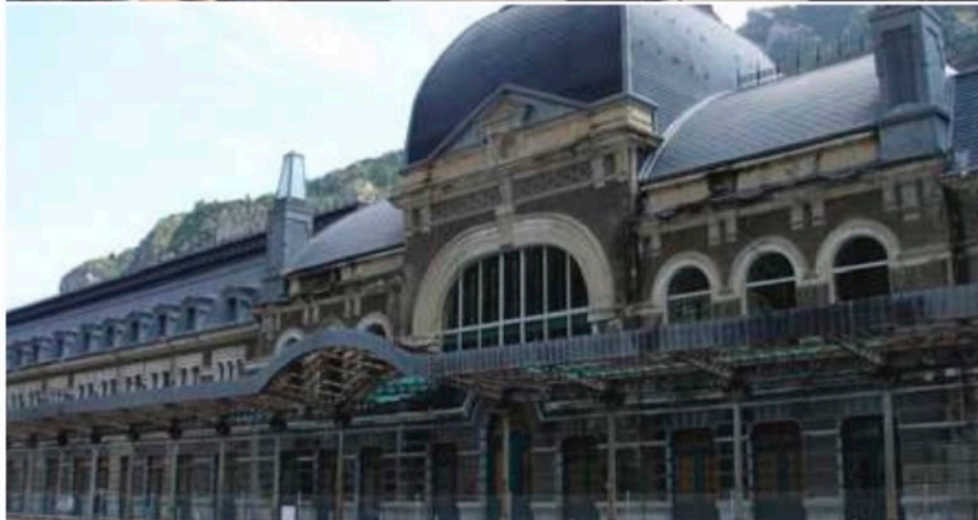
Elus régionaux et locaux, représentants des cabinets d'études sollicités par la Région et des acteurs associatifs, venus du Béarn comme d'Aragon, se sont retrouvés à Accous pour évoquer l'avenir de la gare de Canfranc, photographiée (ci-dessous) avant le début des travaux. ©ASCENSION TORRENT
